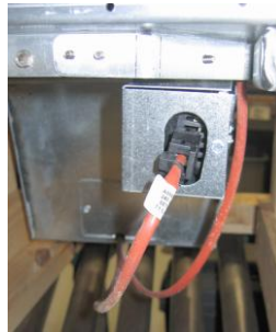
الشكل ٦: أدخل الموصلات البيضاء المزودة بـ ٢ بنز والموصل الأسود داخل صندوق الاستخدام كما هو موضح. يرجى العلم بأنه قد يختلف وضع الموصل الأسود عن الشكل الموضح بالصورة.
